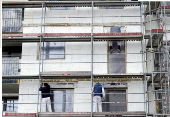
Immer mehr Bauunternehmen geben Aufträge an Subunternehmer weiter. Oft ist das Geflecht der Unternehmen und ihrer Subunternehmen schwer durchschaubar
