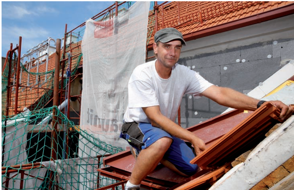
Dachdecker Reinhard Michtics leistet mit seiner Arbeit einen Beitrag dazu, dass Gemeindebaumieter niedrigere Heizkosten haben
