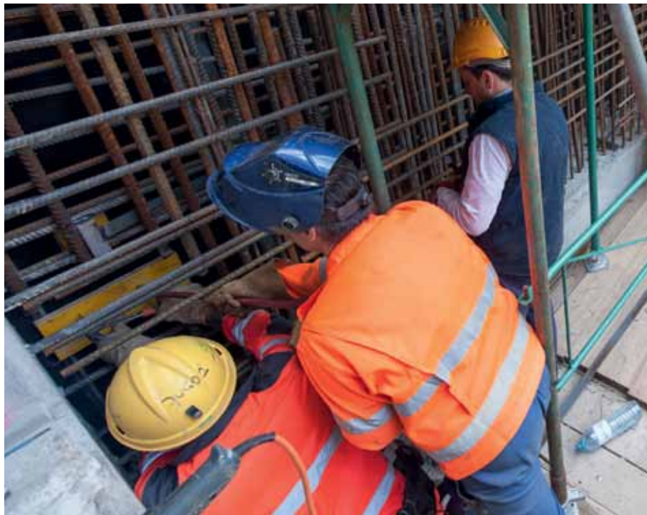
Sicherheit am Bau erfordert gute Koordination
