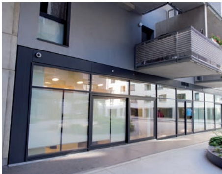
Blickdicht verklebte Scheiben. Eine blühende Flaniermeile braucht andere Geschäfte in den Erdgeschoßzonen
