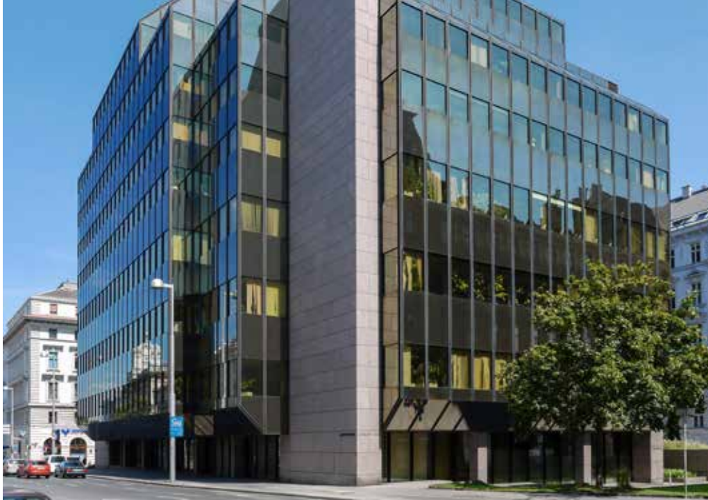
Der Wiener Glaspalast vor seinem Rückbau.
